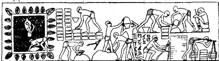
Формовка кирпичей и возведение стен.
